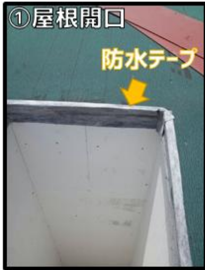
①屋根を開口します。
